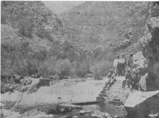
Obras de toma. (Riecillo de Matancillas a 1350 m. sobre el mar)
